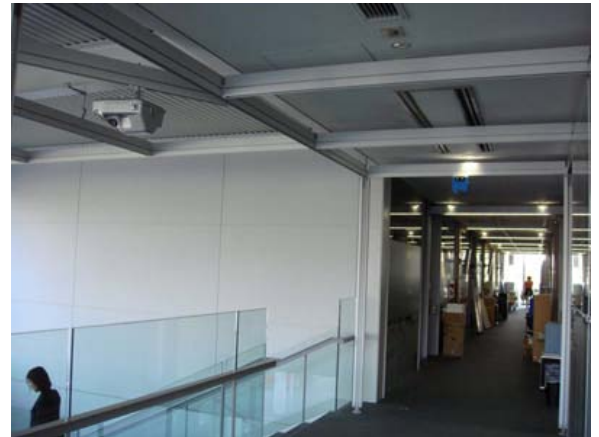
図 6 行者人数カウントセンサとレーザーレンジファインダー
