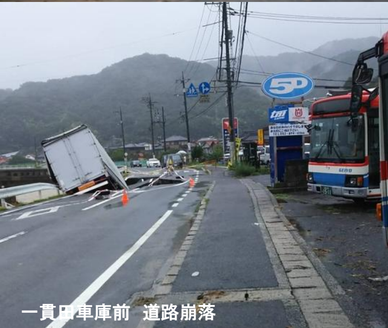
国道2号線 道路崩落
